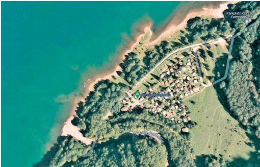
Mit zwei Schutzdämmen soll der Campingplatz Güntlenau im Klöntal vor Hochwasser in den Runsen besser geschützt werden. (Foto: © Google Maps)
